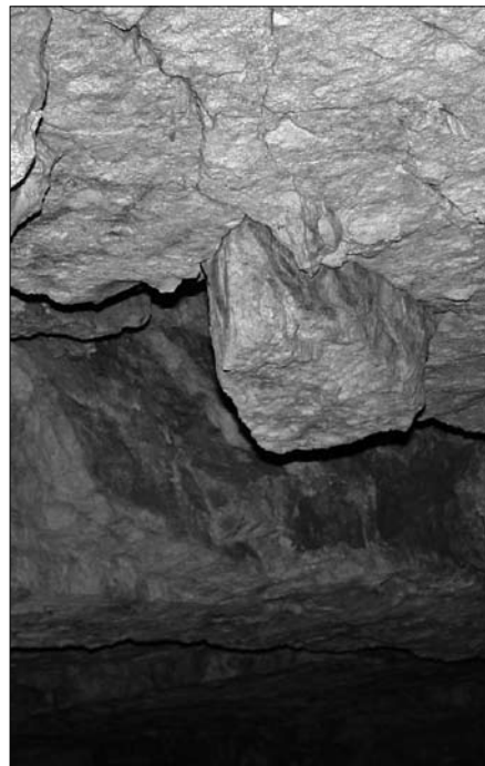
Blok wapienia wysuwający się z odprężonej ławicy stropowej w Sali Przejściowej
