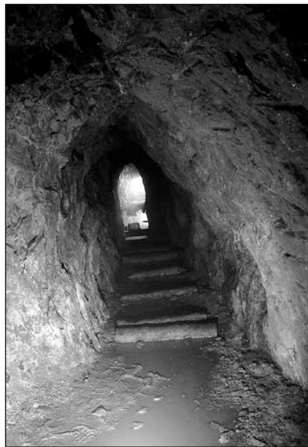
W podziemnych chodnikach kopalni Teresa (lata 80-te)
