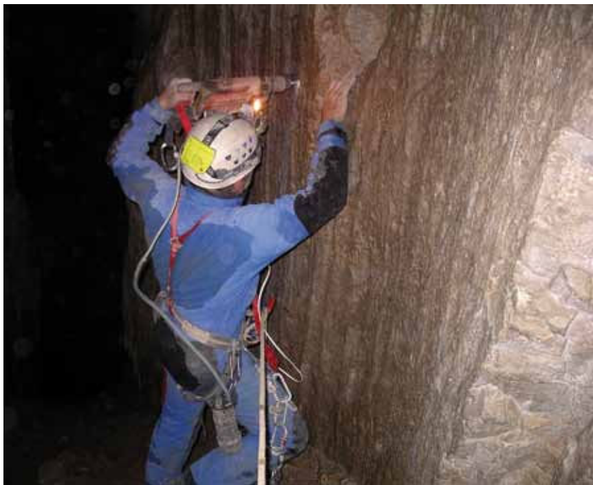
△ Poręczowanie PE001 • fot. archiwum wyprawy
